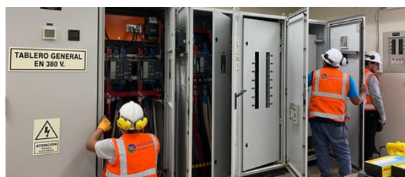
MANTENIMIENTO DE TABLEROS ELÉCTRICOS DE BAJA TENSIÓN
