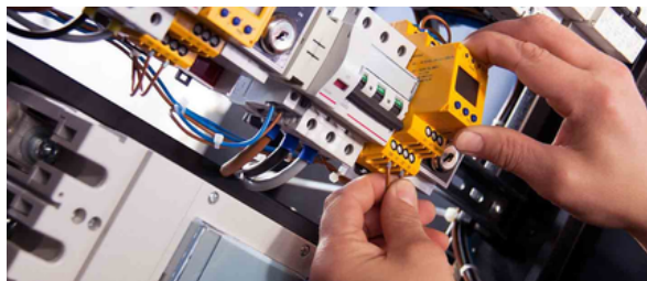
INSTALACIÓN DE EQUIPOS ELÉCTRICOS, ELECTROMECÁNICOS Y AUTOMATIZACIÓN DE PLANTAS INDUSTRIALES
