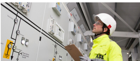
MANTENIMIENTO DE TRANSFORMADORES Y CELDAS DE MEDIA TENSIÓN
