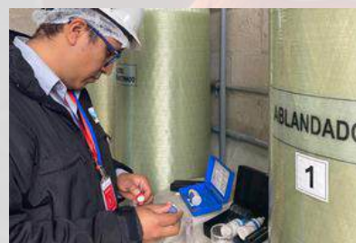
SISTEMAS DE MEDICIÓN DE PH, CLORO Y CONDUCTIVIDAD.
